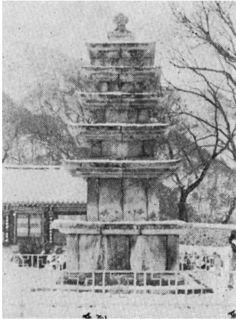
사진 1. 틸을 따라 풍화(風化)가 심하게 일어나 풍화대(風化帶)의 폭(幅)이 더욱 넓어진 현상(무량사오층석탑(無量寺五層石塔) 일층탑신(一層塔身)의 북쪽면)
