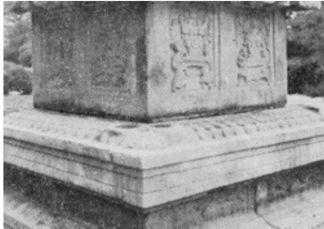
사진4. 탑신과 기단석사이에 심한 풍화(風化)가 진행(進行)되어 떨어져나가고 검게 변하여 있는 현상
