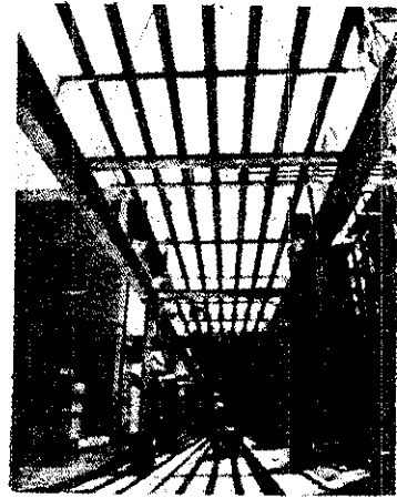
寫眞 3-1 連結用 主配管 (主配管의 밑은 連絡通路로 되어있음)
