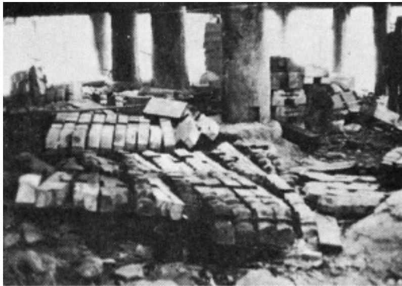
人工木材樹脂로 接着補強한 部材들 인공목재수지(人工木材樹脂)로 접착보강(接着補強)한 부재들
