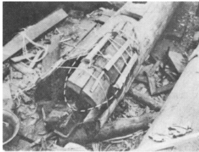
부식부를 他木材로 接着 보강한 상태
