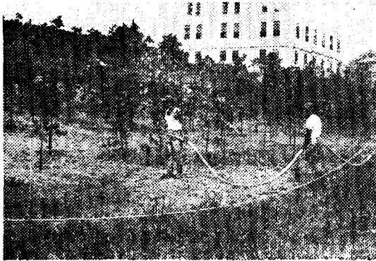
그림 5. 씨뿌어넣이기工法에 의한 綠化施工 Fig. 5. Vegetation establishment measures by the hydroseedings
