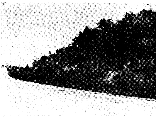
그림 1. 植生工法으로 綠化된 路邊비탈면의 再崩壞 Fig. 1. Slope sliding caused by the excess water
