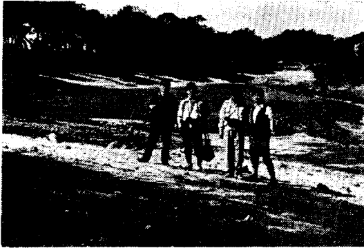
그림 1. 義林池堤防이 破壞되어 물이 빠진 모습(後面 右側이 破壞된 堤防) Fig. 1. The view of Eui Rim Reservoir after water drained through destroyed embankment
