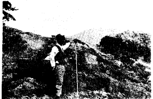
그림 3. 義林池堤防의 築堤技術을 調査하고 있는 光景 Fig. 3. The construction techniques of the embankment has been inspected.
