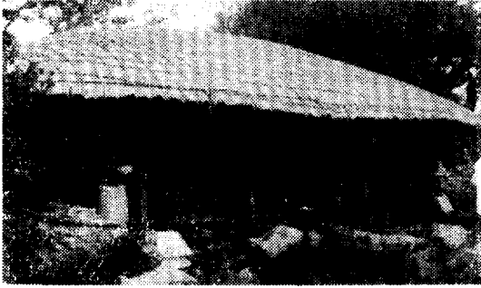
사진 2. 3間型 民家. 南濟州郡 南元面 新禮里 778
