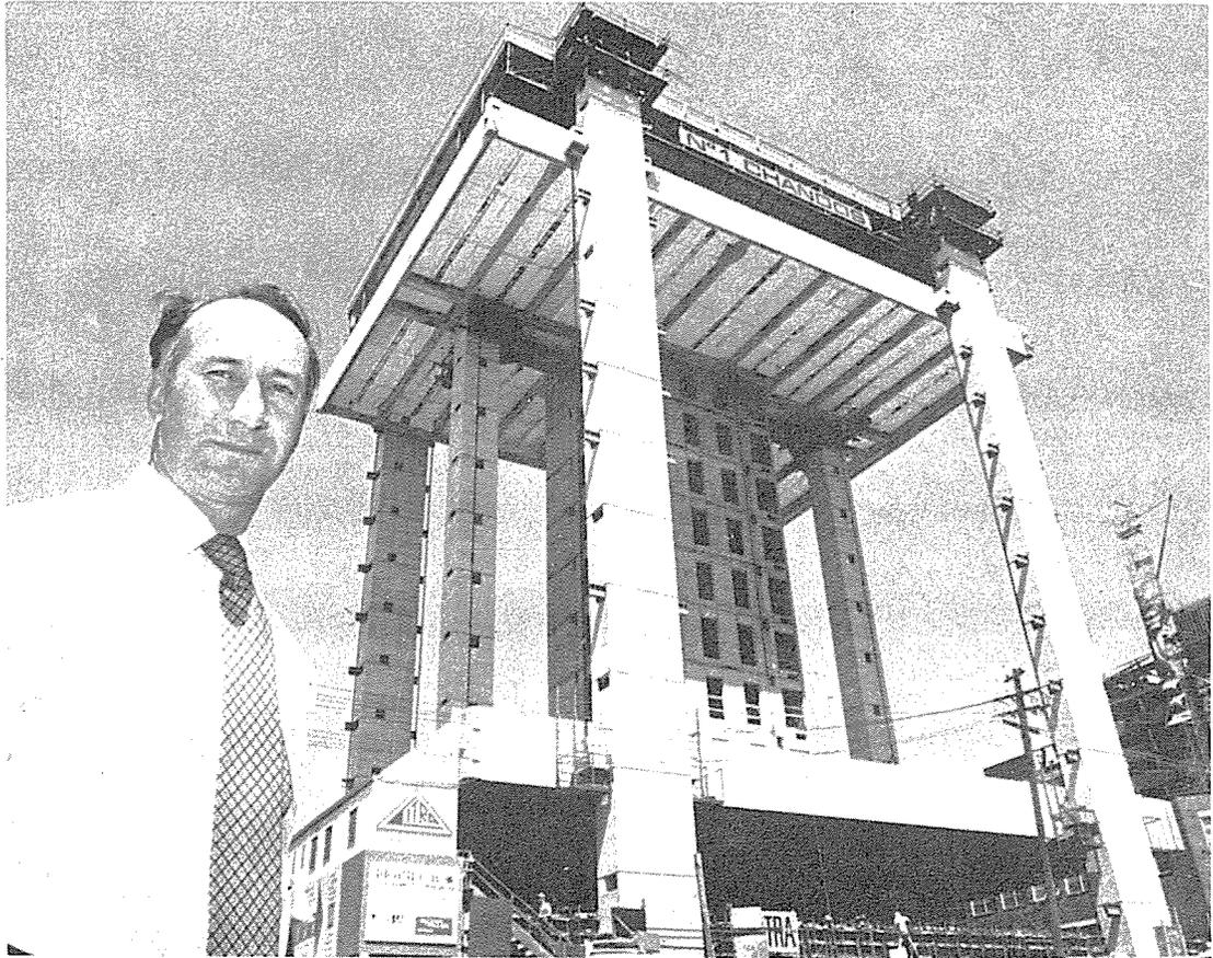
건축地위의 基準層으로 각층들을 끌어 내림으로서 建물을 完成시키는 새로운 建築工法이 오스트라리아의 기술디자이너에 의해 개발되었다.
