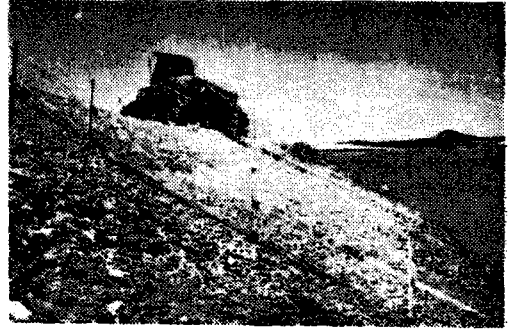
사진 3. 쉘타 시공 광경
