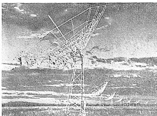
시드니 北北西方向 560 km의 Narrabri라는 都市(人口…6千) 근처의 Culgoora(컬구라)의 太陽電波望遠鏡(radiobelio graph)을 使用하여 얻어진 太陽活動에 對한 새 데이터와 그 裝置에 對한 說明을 엮어서 만든 映畫였다. 말하자면 直徑이 3km나 되는 電波望遠鏡에 對한 얘기인 것이다. 그런 큰 望遠鏡의 받침臺는 만들 수가 없는 까닭에 96개의, 1306 m의 直徑을 가진 작은 望遠鏡을 3km 圓周上에 늘어 놓은 것이다. 筆者도 위에서 말한 막카스카 교수의 공기사위 계측기군의 구경과 결드터 이 電波望遠鏡을 求景하러 Narrobbri까지 일부러 가서 求景했었다. 호주의 自然科學 특히 宇宙科學에 對한 热誠을 볼
