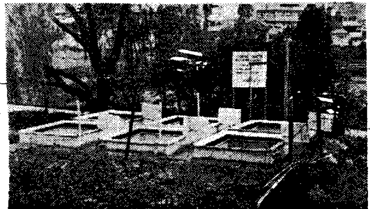
Fig 1. Floting Lysimeter 設置光景
