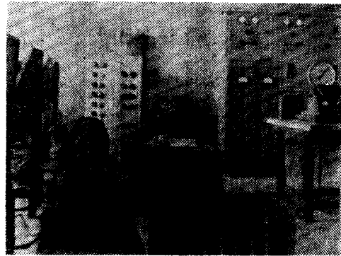
그림 2. 電氣機器室의 一部
