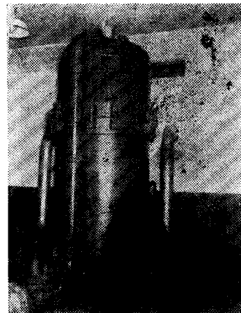
그림 1. 燃料 濾過 및 水分 分離器(Filter/Seperator)
