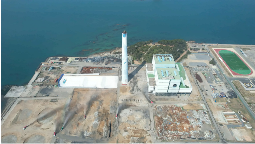
Fig. 1. 폐 화력발전소 철거
