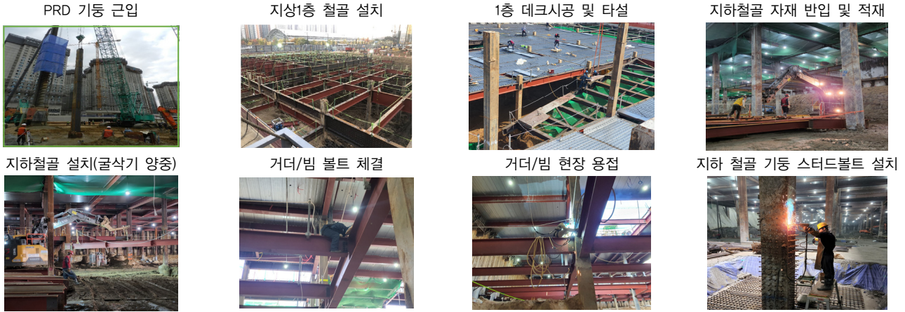
그림 1. 지하 철골공사 시공순서
