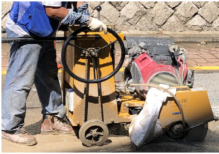
그림 1. 재래식 도로절단기의 절단 작업 [2]
