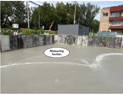
그림 1. Mock-up test 부재 사진
