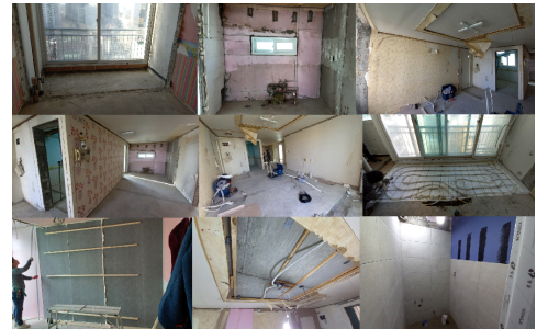
그림 3. 리모델링 공사 사진
