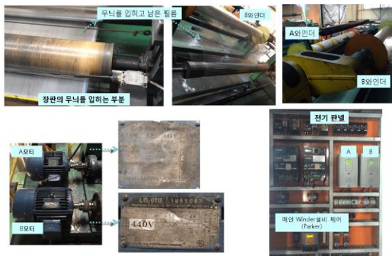
그림 9. PVC장판 생산업체 Winder 전용화 대응 현장사진
