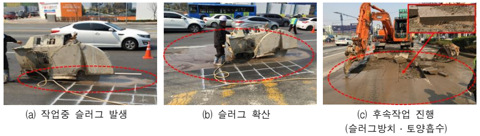
그림 1. 절단슬러그 발생, 확산 및 방치 사례 3)
