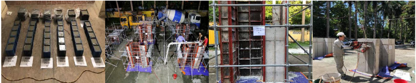
a) 공시체 제작 b) 목업부재 레미콘 타설 c) 거푸집 탈형(타설 12시간 후) d) 코어채취 및 압축강도 측정 그림 1. 초유지 고강도 콘크리트 목업 실험
