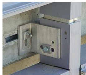
그림 1. 기존 커튼월 수직부재 연결방식
