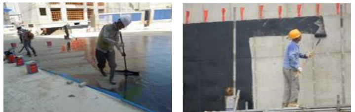
그림 1. 방수공사 바닥/수직부 시공 현장실태
