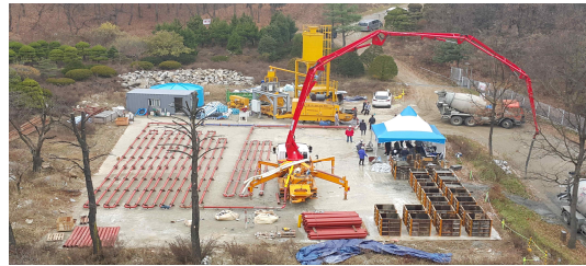
그림 4. 현장 시험 실물 전경
