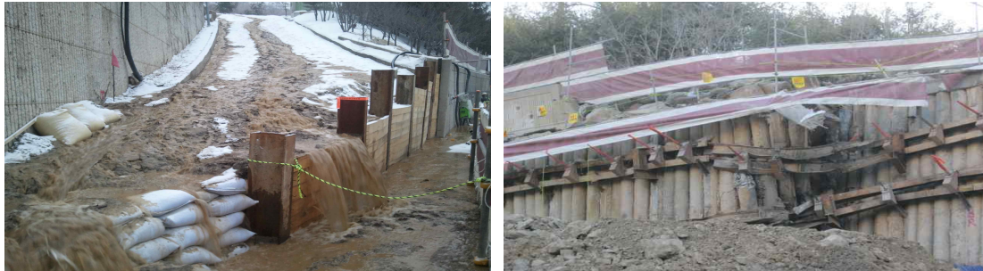
그림 1. 연구지역 흠막이 변형 및 사면 인장균열
