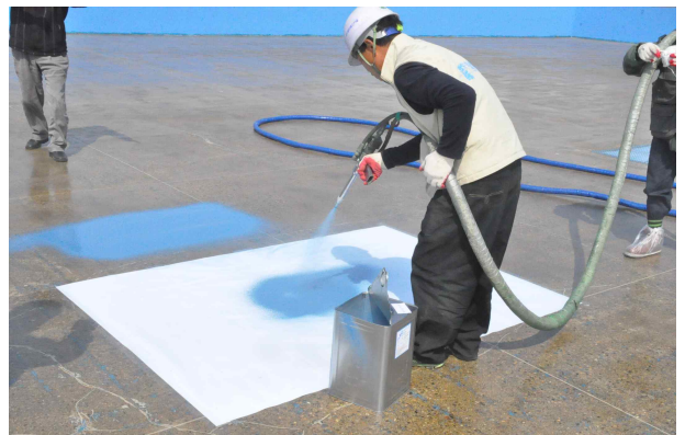
사진 3. 폴리우레아 도포 현황
