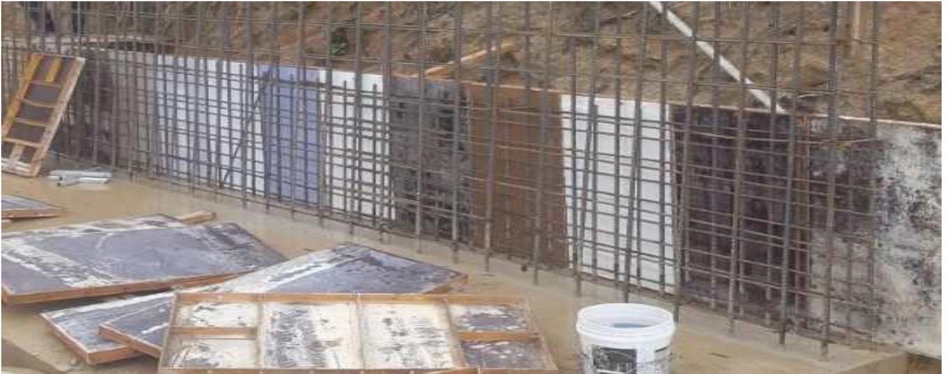
그림 1. 코팅재부착 옹벽거푸집 설치
