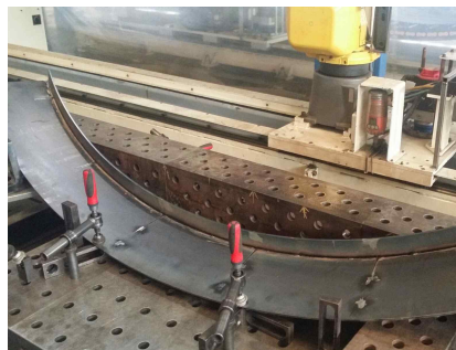
조립 및 용접
