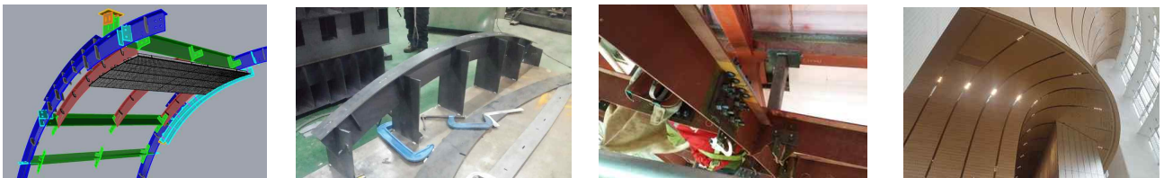
그림 3. 롯데월드타워 타워동 포디움, CNC T-BAR 조립 및 비정형곡면 마감재 설치공사
