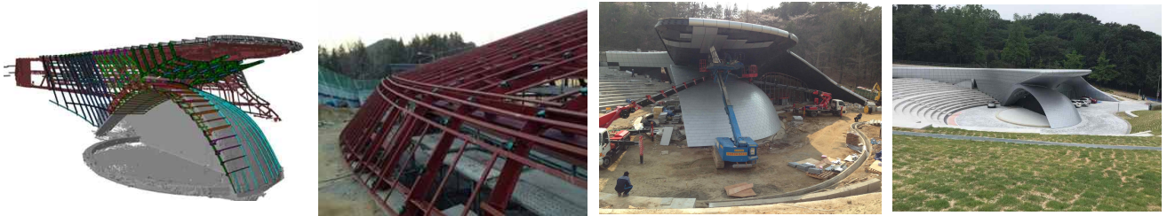
그림 2. 서울대 원형공연장(풍산마당) CNC T-BAR 조립 및 비정형곡면 외장재 설치공사
