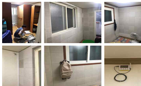
그림 2. 세라믹패널 시공 및 온·습도 센서 설치
