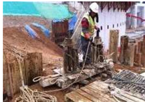
그림 4 강널말뚝(sheet pile)-차수 그라우팅
