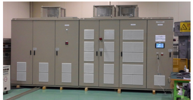
그림 8 개발된 13,800V/2,400kVA 고압인버터
