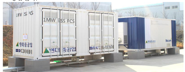
그림 2 1MW PCS 컨테이너(좌) 및 1MWh 배터리 컨테이너(우)
