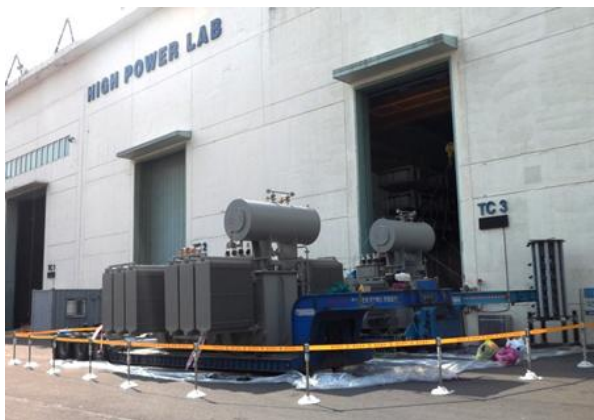
그림 2 CCU/L-1 컨버터 변압기의 42 kApeak 단락전류시험 Fig. 2 Short-circuit withstand test at 42 kApeak for ITER CCU/L-1 ac/dc converter transformer
