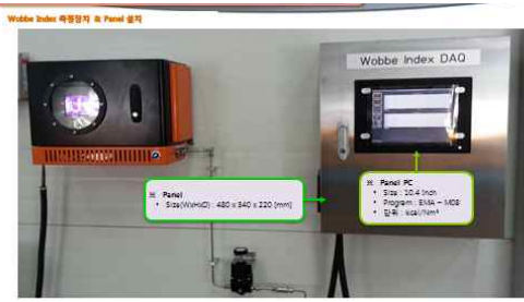
Fig.7 열량계(WI) 측정장치 시스템 설치
