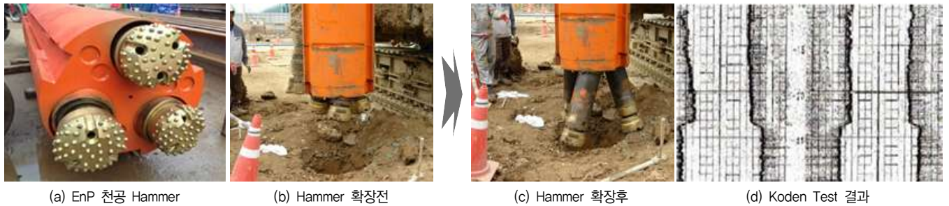
그림 6. 선단 확장 PRD 공법
