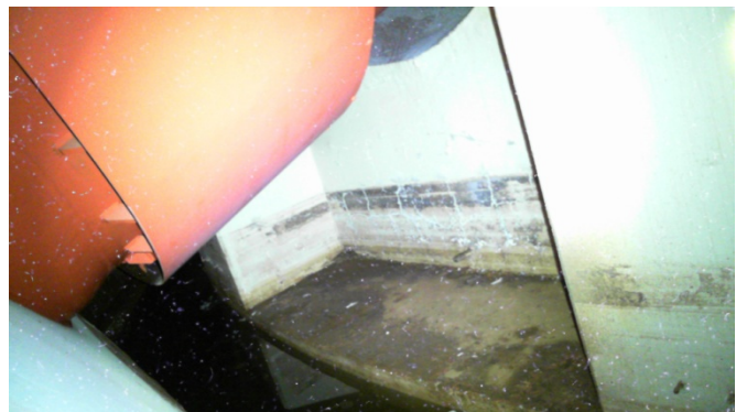
(그림 4) 8 번 Vent 관의 Sleeve 부위 조사영상 [5]
