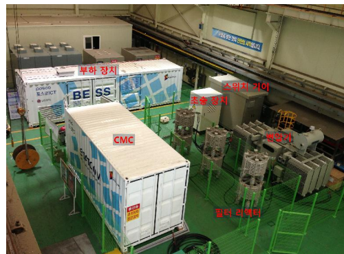
그림 5 22.9kV 5MVA STATCOM의 설치도
