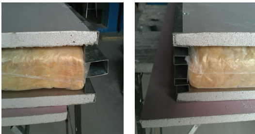
Picture 12 조립식 유닛 패널의 결합부위
