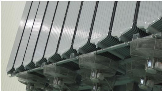
Figure 1 대용량 변압기 냉각시스템
