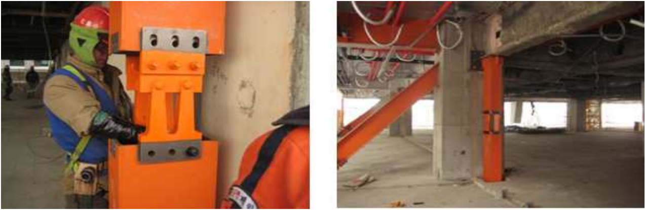
그림 5. 이동형 제진댐퍼 시공 전경
