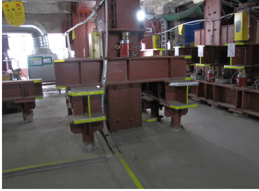
사진 1. 뜬구조 공법 현장사진
