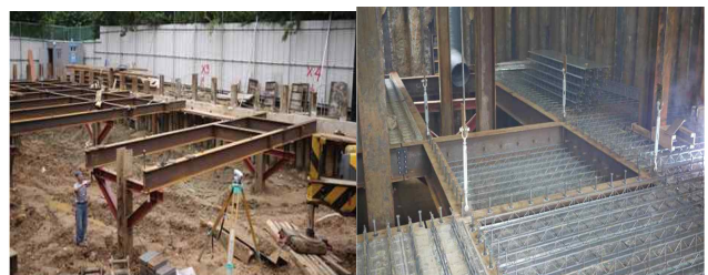
그림 4. DBS 공법의 시공사진
