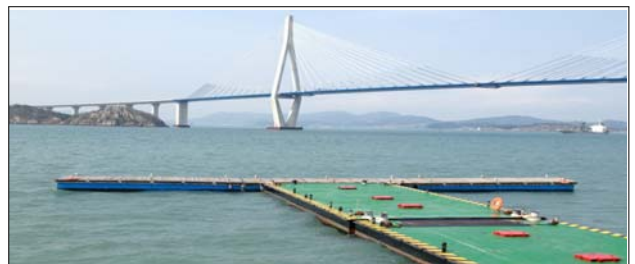
Fig. 1 small mooring facilities(목포해양대학교 마리나 시설)
