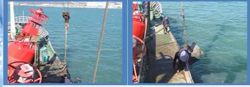
기존 인양작업 시 석사슴에 연결고리를 걸어 인양작업
