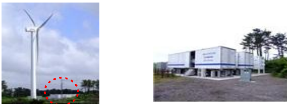
그림 4 설치현장 전경 Fig. 4 Installation Site
