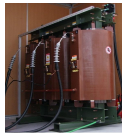
그림 2 주변압기, C-GIS Fig. 2 Main Transformer, C-GIS
