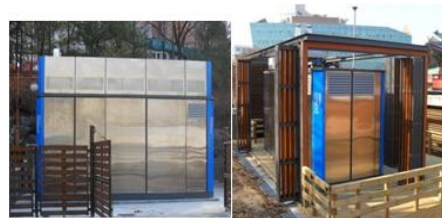
그림 2 100kW 연료전지[서북병원(좌), 어린이대공원(우)]
