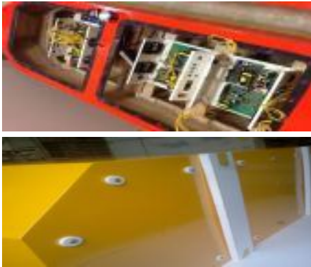
그림 3 시스템 장착 Fig. 3 Installation of system
