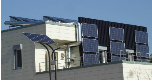
그림 4. BIPV/T 설치사진
