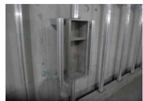
그림 4. 수직 빔지지 공법 상세 사례
