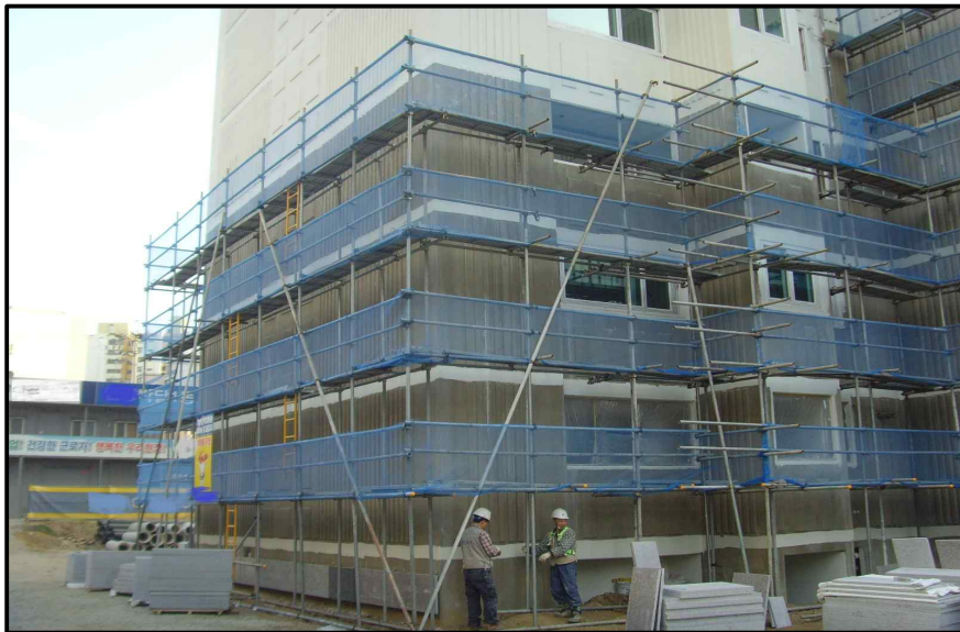
Fig. 4 건설현장의 강관비계 조립 사진
