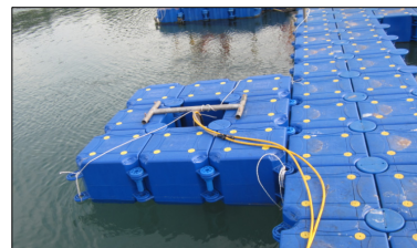
Fig. 2 현장에 설치된 감시 시스템의 수중체
